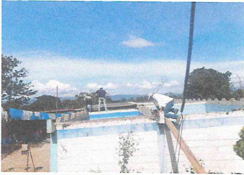
Foto 1: Durante el desmontaje de techo de aulas.
