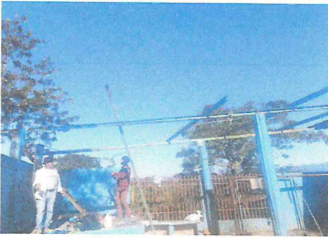
Foto 3: Durante el desmontaje de techo en corredor.
