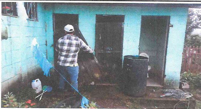
Foto 3: Durante el retiro de puertas antiguas de sanitarios
