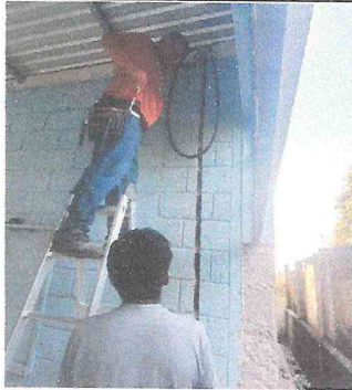
Foto1: Durante ducteado para sustitución de sistema eléctrico.
