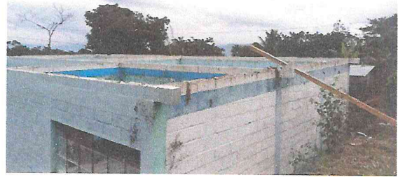
Foto 4: Nivelación de paredes para colocar estructura metálica.
