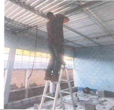
Foto 2: Ducteado para sustitución de sistema eléctrico en aulas.
