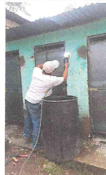
Foto 4: Durante la colocación de puertas nuevas en sanitarios.
