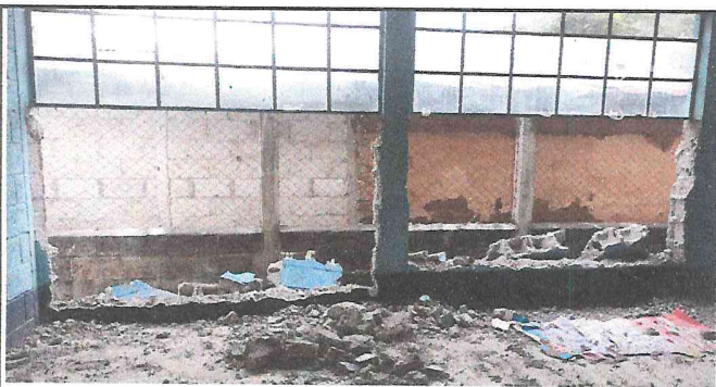
Foto 5: Derribamiento de paredes para reforzar paredes en aulas.
