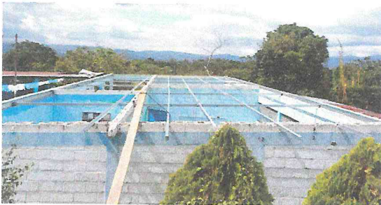
Foto 5: Durante la colocación de estructura metálica.
