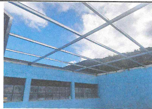
Foto 6: Estructura metálica parte interior de aulas.
