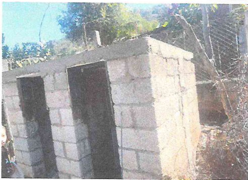
Foto 3: Preparación de reforzamiento de paredes para base fundida de concreto para depósito de agua.
