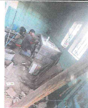
Foto 4: Durante la sustitución de mesa de concreto en cocina.
