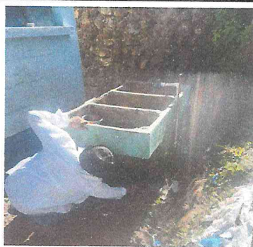
Foto 5: Durante sustitución de pilas de cemento.
