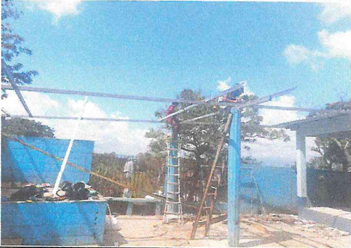
Foto1: Durante colocación de costaneras en corredor.
