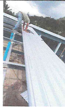
Foto 2: Durante enlaminado en corredor.
